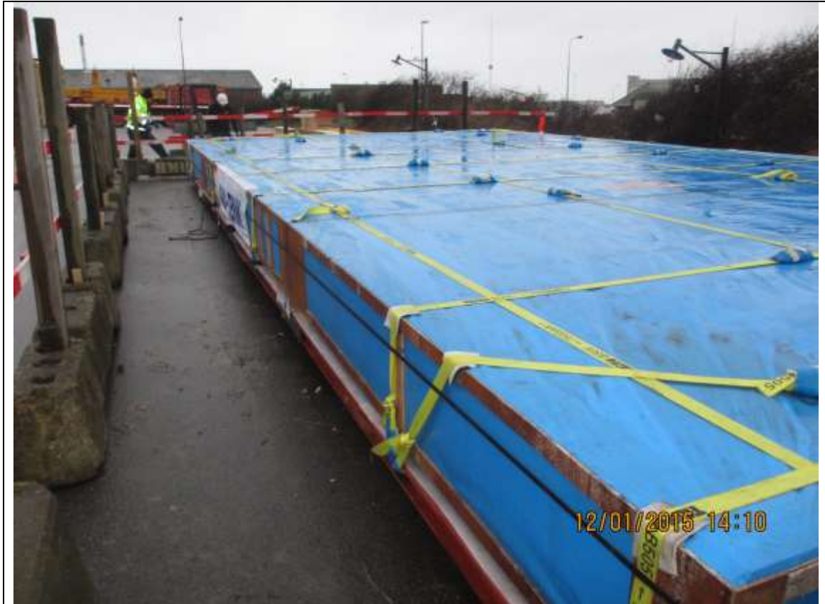
Panoramaruden 12300 x 6340 x 420 mm, 38 m.t. var oplagt på transportramme ved NØ ende af Nordsøen Oceanarium
