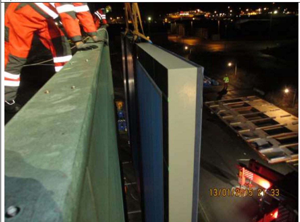
Panoramaruden hænger i hovedkranen med en slagside på 0,8^\circ mod vandsiden og er klar til indløftning når vinden lægger sig.
