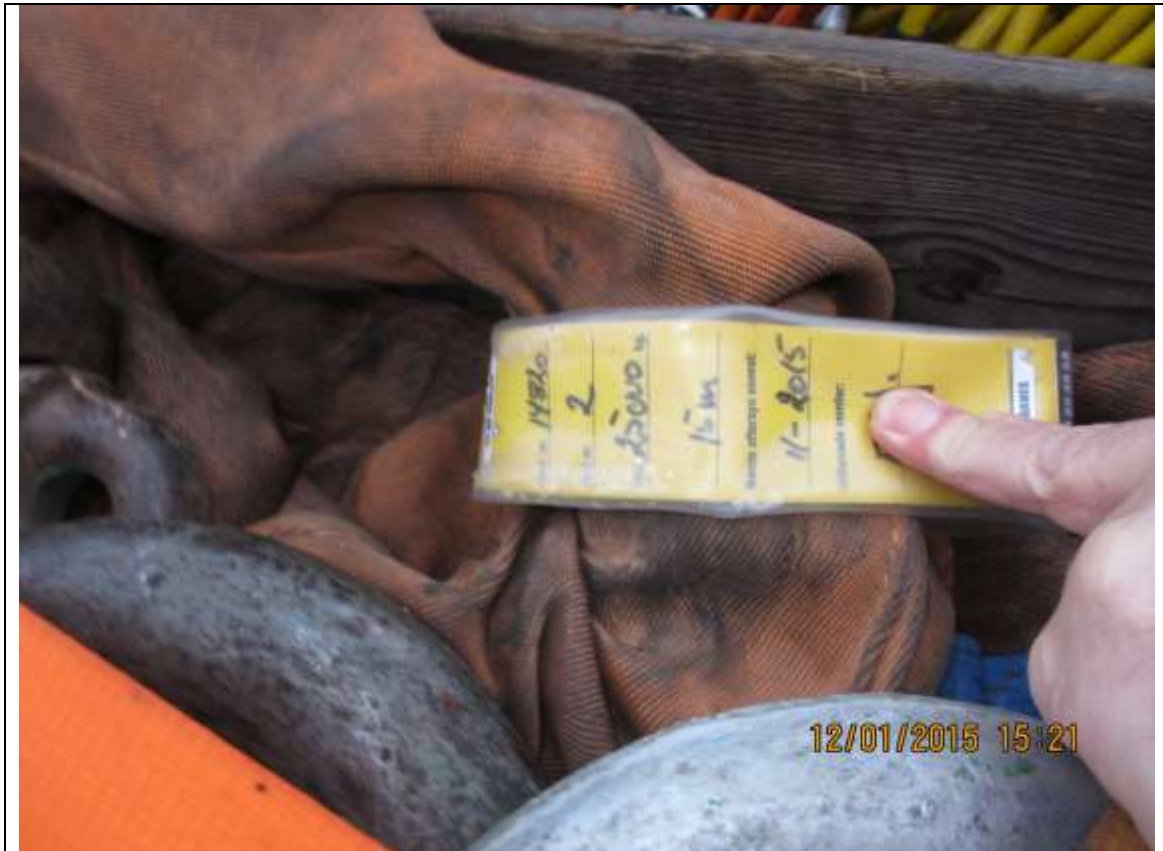
Løftegrej, der tænkes anvendt, blev gennemgået uden bemærkning.
