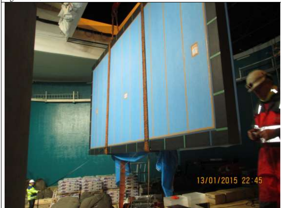
Ruden hænger stabilt i hovedkranen klar til svajning mod uret.
