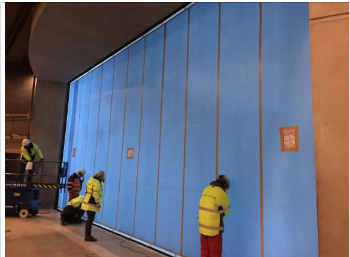
Kl. 02.20 bekræfter lederen af det japanske fugeteam, at ruden står i den ønskede position målt langs publikumssiden.
