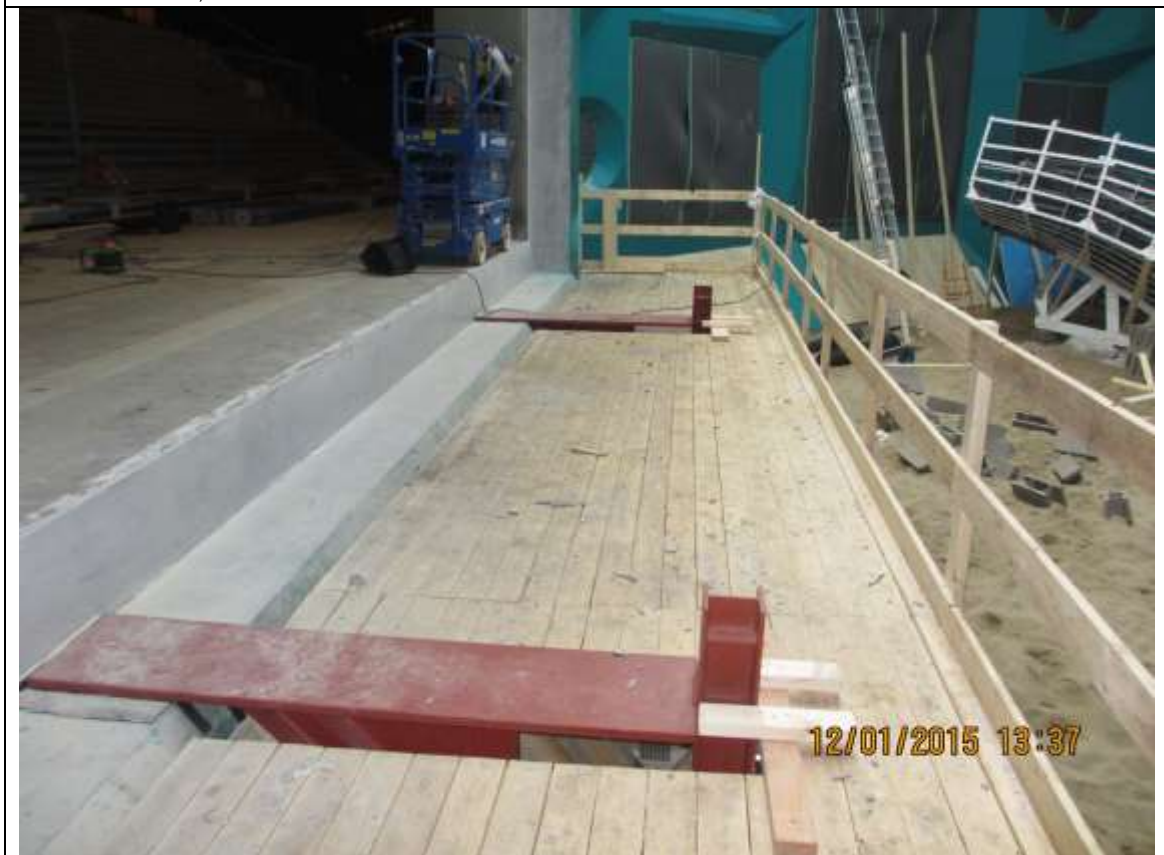
Ruden affires på indsliskningsprofil. Der anvendes kantskåner og mellemlæg for indbaksning på skridplader.
