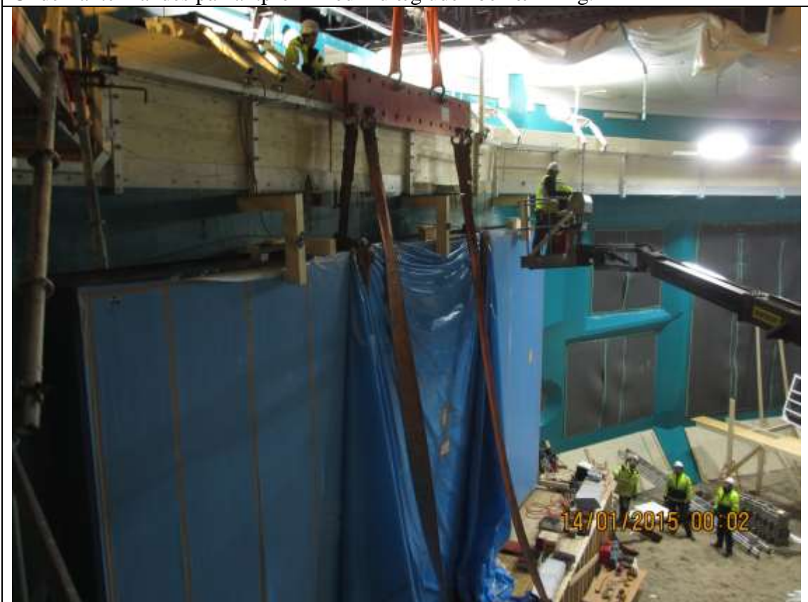
Trykfødder langs topkant justeres løbende under den horisontale forskydning.
