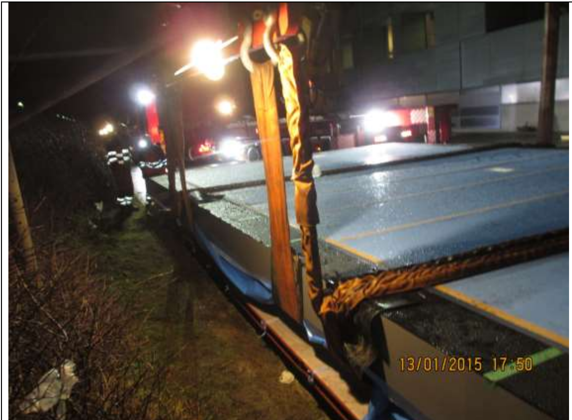
Kl. 18.00 løftes ruden for tilpasning af syet slæng og rundslæng mellem hoved- og støttekran.
